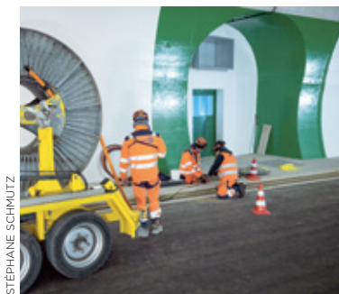
16 - Au cœur du tunnel des Évouettes
